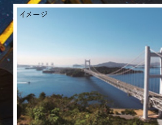
瀬戸大橋(倉敷市) 本州と四国を結び、道路・鉄道併用橋としては、世界最大級の橋
